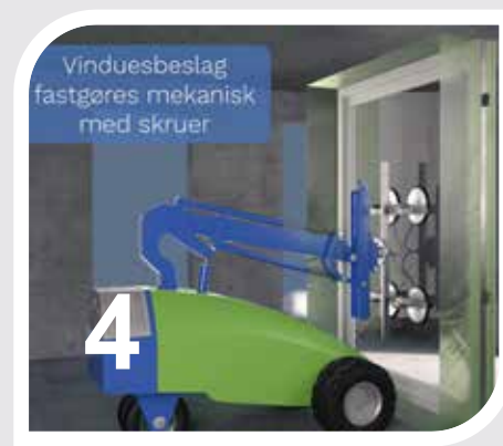
Step 4 - Fastgørelse af dampspærre og beslag
