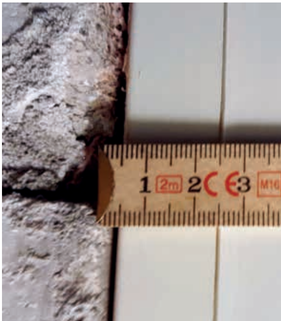
En karm monteret med for lille en fugebredde. Det er således ikke muligt at brandsikre fugen korrekt.
