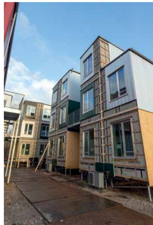
En varmepumpe per blok er nok til at klare både opvarmning og varmt vand for op til 12 boliger.
