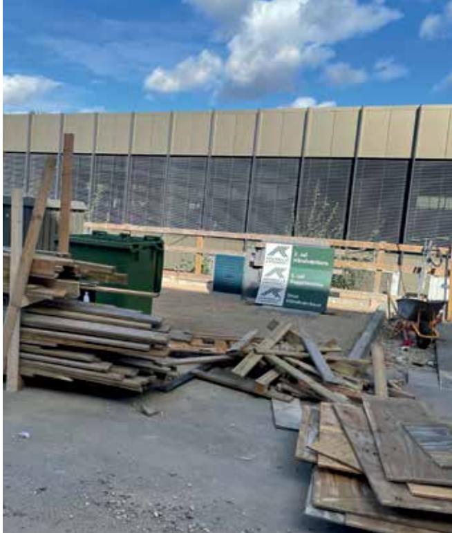
For at sortere optimalt skal man fjerne skruer og deponere ubehandlet træ, imprægneret træ og træplader hver for sig, siger Sten Bjerre (tv).
