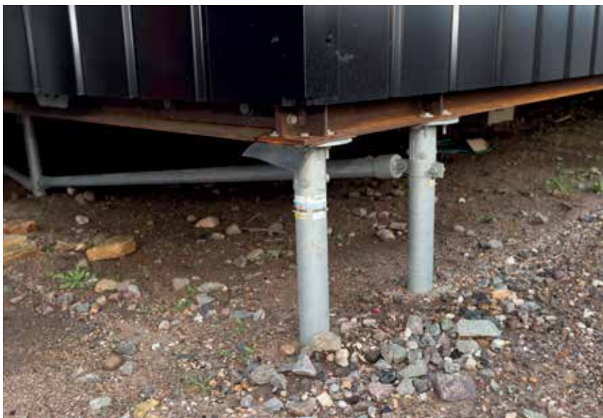
Skruefundamenterne, som går 3-4 meter ned i jorden, reducerer CO 2 -aftrykket væsentligt, da man dermed undgår at bruge betonfundamenter.
