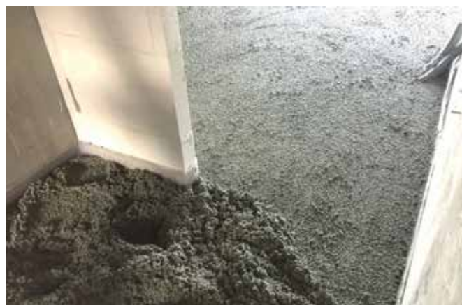
Ensartet EPS-beton med cementbindemiddel uden synligt hvidt EPS-tilslag.
