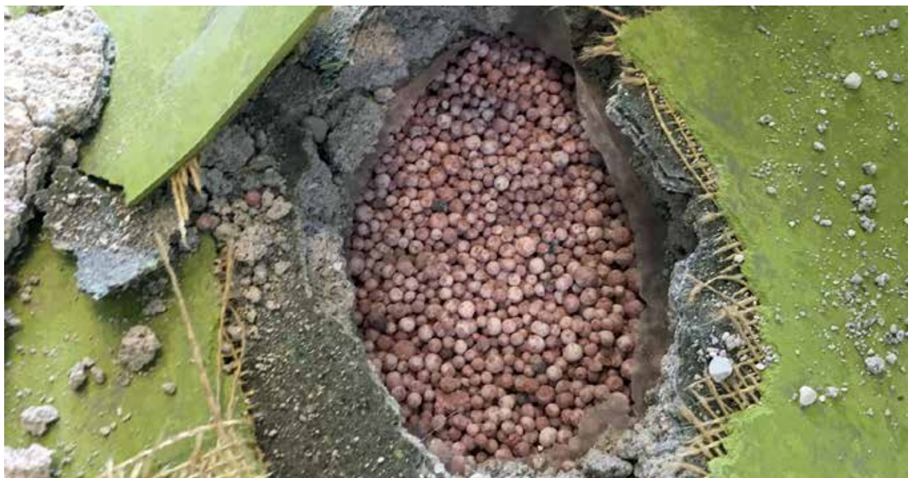
Nedbrudt gulv med løst EPS-tilslag (EPS-kugler).
