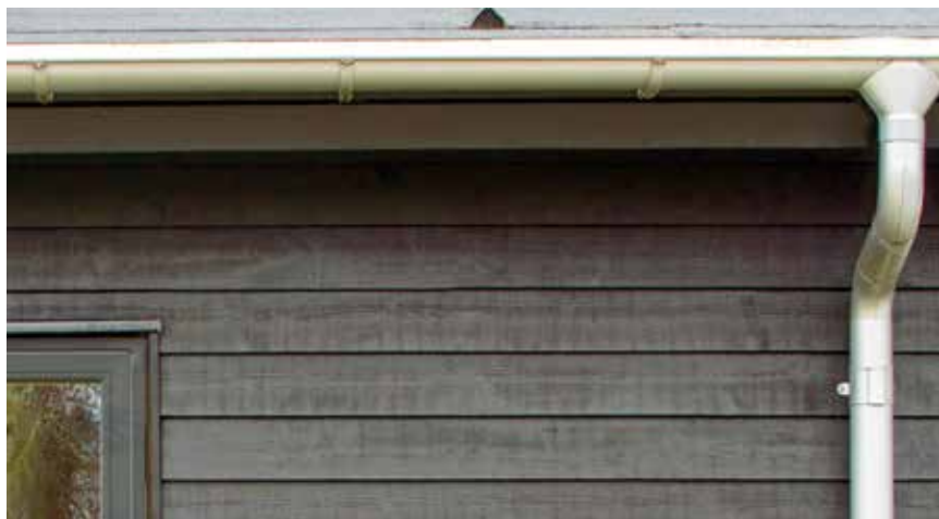
Her ses en regnskærm af træ. Vindspærren bagved er i brandteknisk henseende bygningens udvendige brandbeskyttende overflade (se også tabelfiguren med de tre eksempler).
