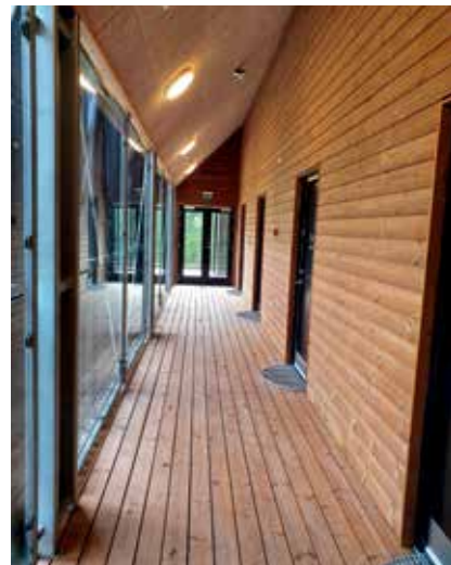
Her ses Naldtang Feriekoloni i Varnæs, som A78 Arkitekter i dag ikke lovligt kunne være ene-rådgiver for. Foto A78
