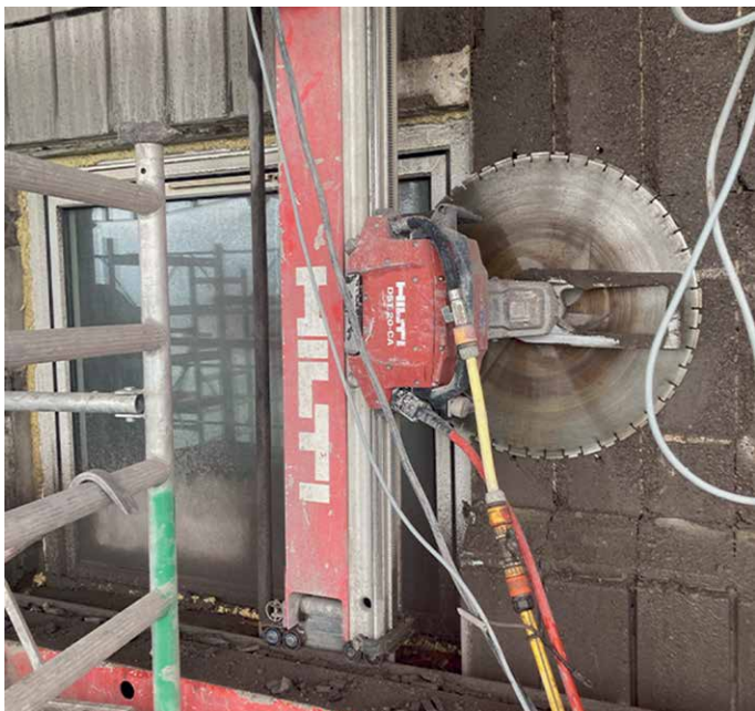
Skæring af 15 cm letbeton i facader.
