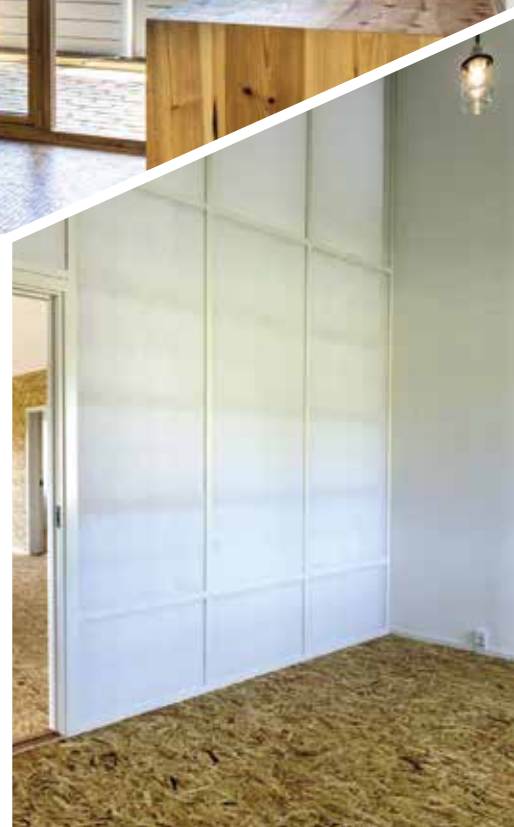
Den hvide væg ud mod alrummet er en termisk masse-væg, skabt af fyldte vanddunke i genbrugsplast. Gulvet er belagt med limfri OSB-plader.
