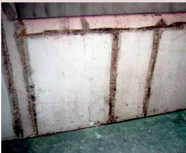
Skimmelvækst – på grund af høj luftfugtighed – på spartelmasse med organisk indhold over samlinger af letklinkerbetonelementer.
