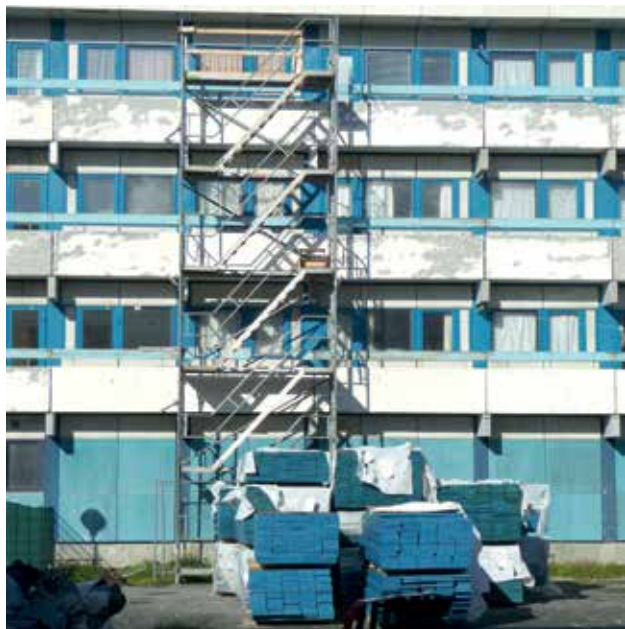
Etageboliger fra cirka 1970 i gang med at blive renoveret.
