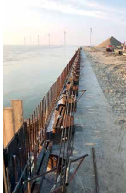
Omkring en fjerdedel af de 65.000 ton sten – som er anlagt på hver side af kajen for at holde på sandet i baglandet – er transporteret med skib fra Norge. Til højre ses, hvor langt selve kajen var kommet i slutningen af marts 2022.
