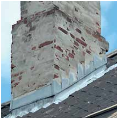
Aftrappede zinkløskanter.
