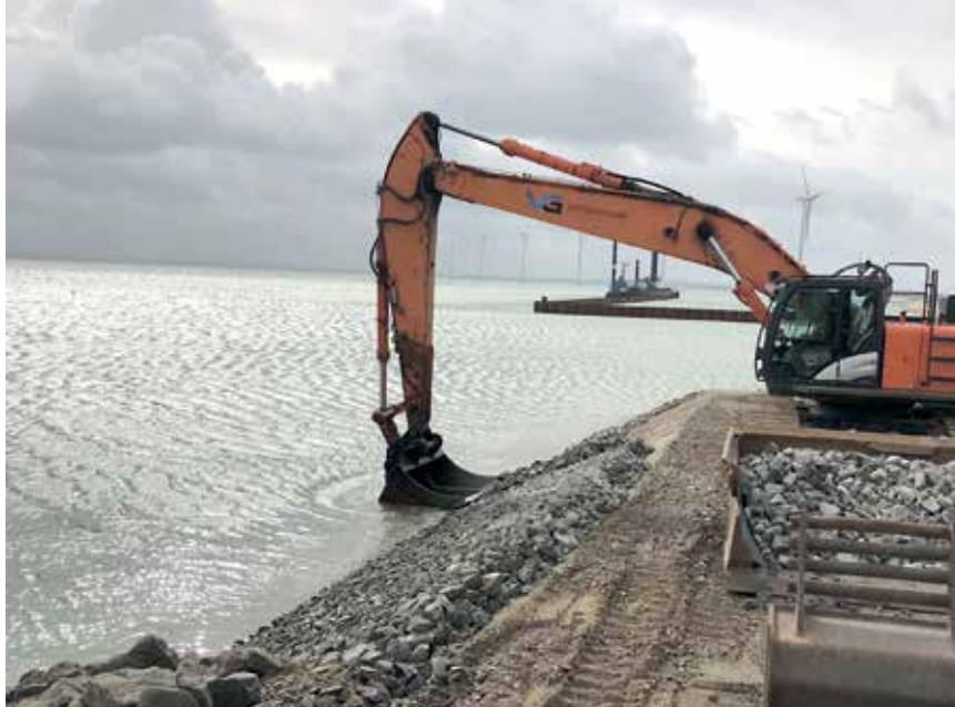
Omkring en fjerdedel af de 65.000 ton sten – som er anlagt på hver side af kajen for at holde på sandet i baglandet – er transporteret med skib fra Norge. Til højre ses, hvor langt selve kajen var kommet i slutningen af marts 2022.
