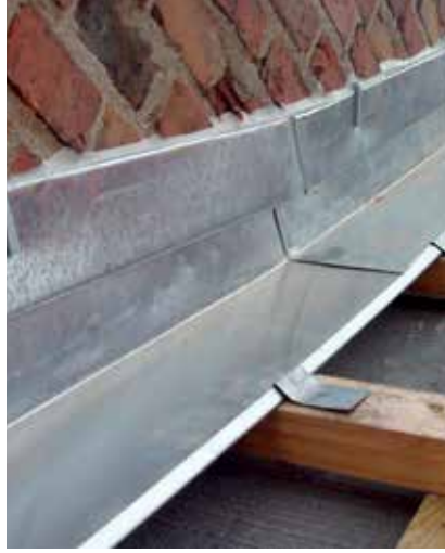
Siderende af titanzink. Undertaget er ført helt op under zinkløskanten.
