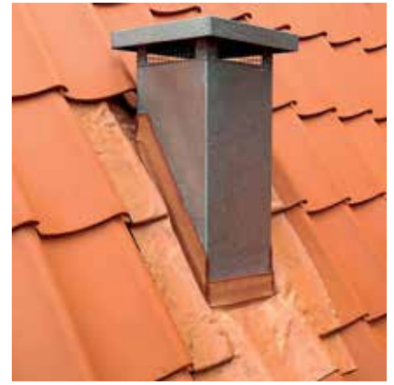
Inddækning af aftræk fra mekanisk udsugning udført i kompositmateriale.
