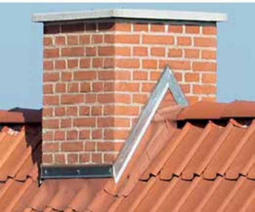
Løskant indlægges i rille i murværk, og der afsluttes med fugning.
