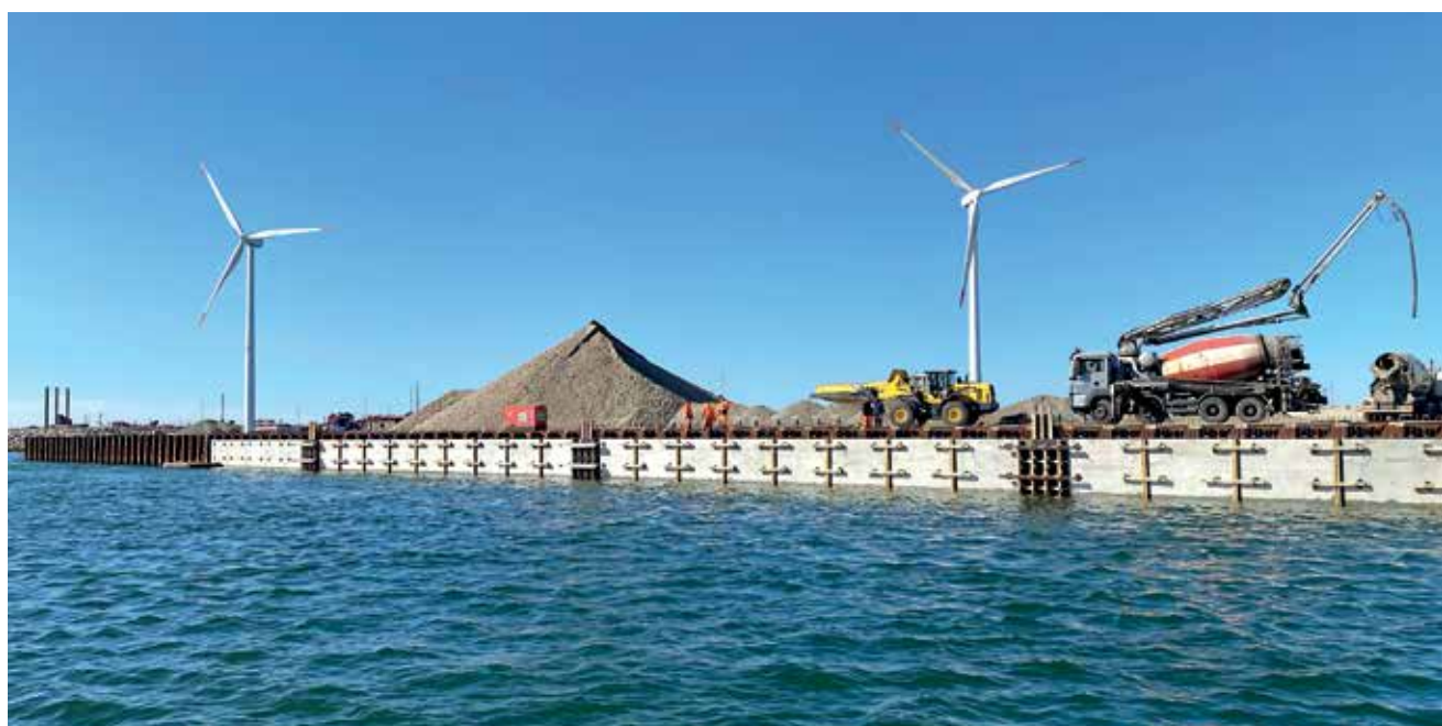
Når kajen står færdig, har sandsugningen øget vanddybden til 10 m, hvilket gør det muligt for store fragtskibe at lægge til kaj.
